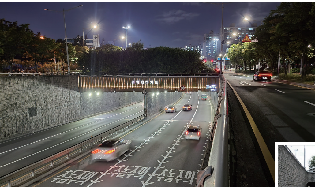
지하차도 경관개선 사업 후
